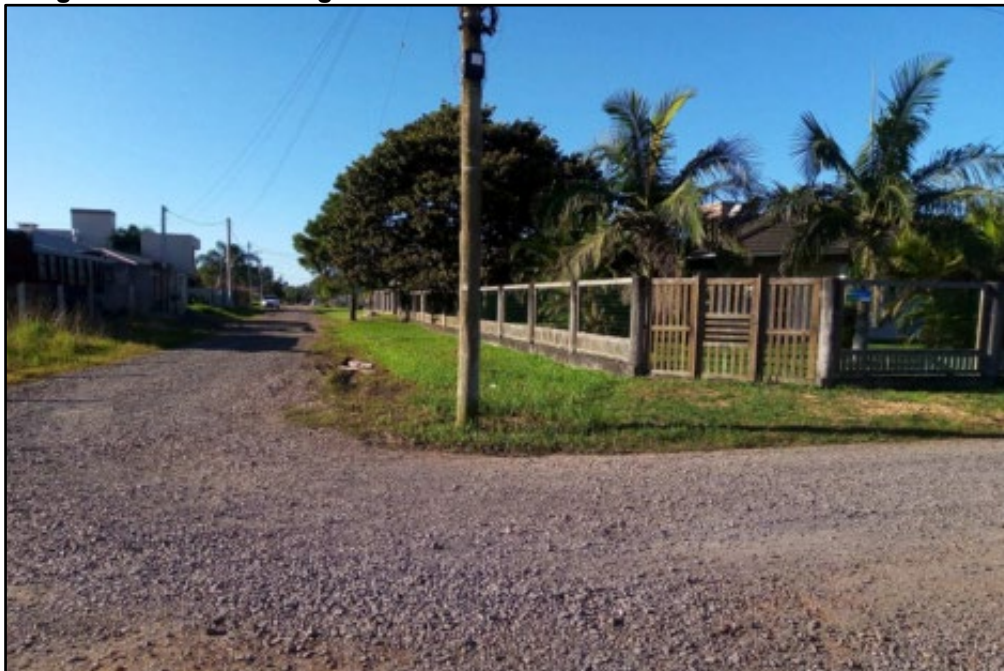
Figura 39 - Área de alagamento com chuvas intensas na rua José Quadros.
