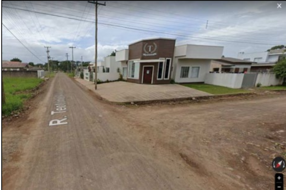
Figura 38 - Ponto de Alagamento na rua Teotônio Vilela.
