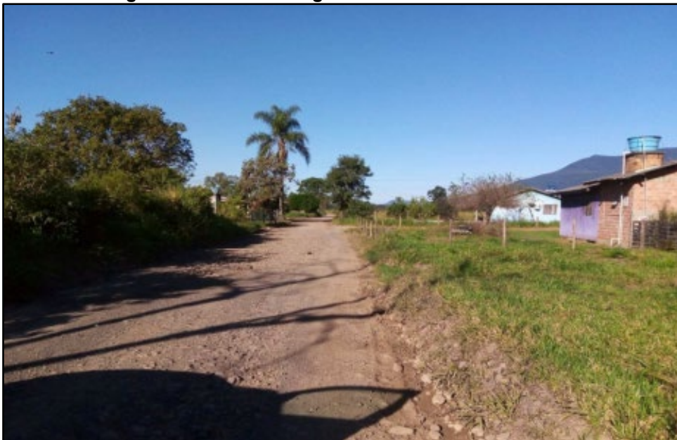
Figura 41 - Área de Alagamento na rua Inácio Justin.
