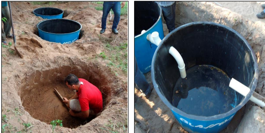
Figura 8 - Exemplo de instalação da fossa biodigestor.
